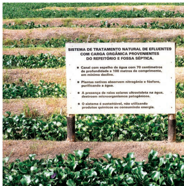
Sistema de tratamento natural de efluentes com carga orgânica provenientes do refeitório e fossa séptica.
