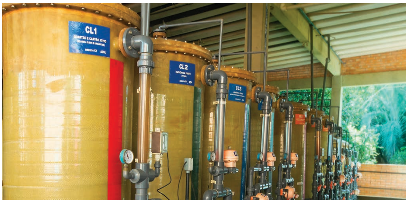
Estação de Tratamento das águas de lavagem da galvanoplastia em circuito fechado, com processo de resina de troca iônica.
